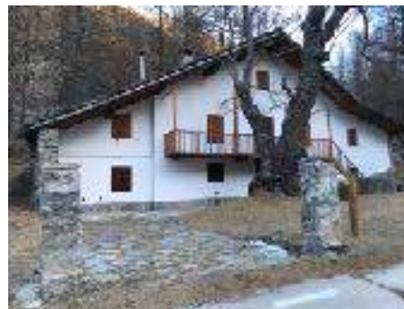
Casa di tipo di alpino con successivi ampliamenti laterali e prolungamento delle falde del tetto.
