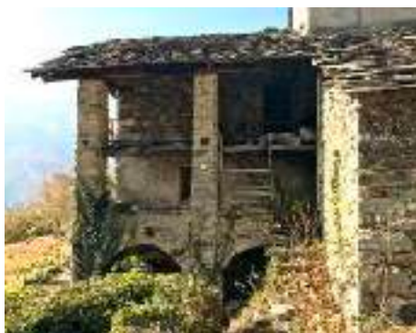
Casa con archi al piano terreno e pilastri nei due piani successivi
