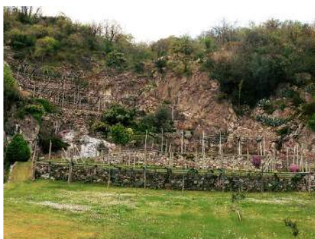
Terrazzamenti a Montalto Dora
