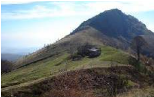
Edificio di alpeggio in Valle Sacra
