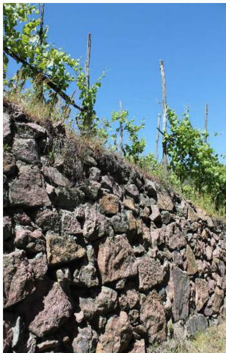
Terrazzamento a Valperga
