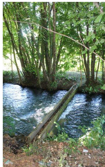
Derivazione presso il canale Caluso ad Agliè
