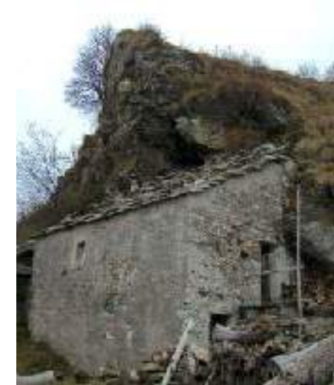
Edificio in pietra addossato alla roccia
