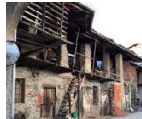
Casa con pilastri al primo piano
