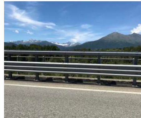
Guard rail in metallo a doppia altezza che offre una efficace barriera di contenimento ma limita la fruizione visiva del paesaggio.
