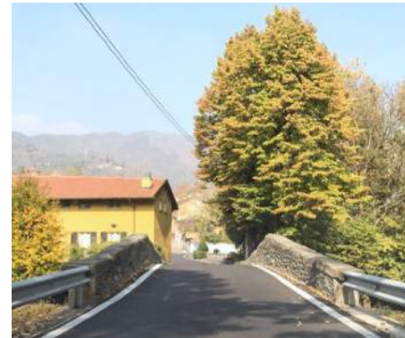
Cambio di protezione stradale nel passaggio sopra un ponte di pietra.
