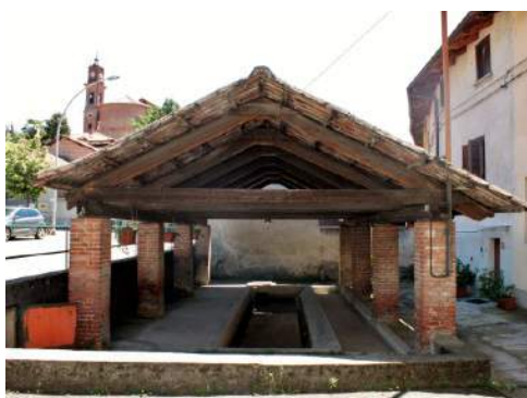
Lavatoio ad Agliè
