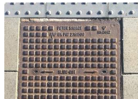
Pavimentazione tattile chiusino
