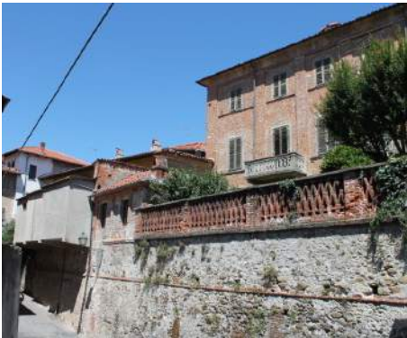
Muri di contenimento in pietra e laterizio.
