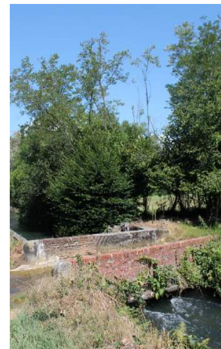
Canali, sponde e attraversamenti
