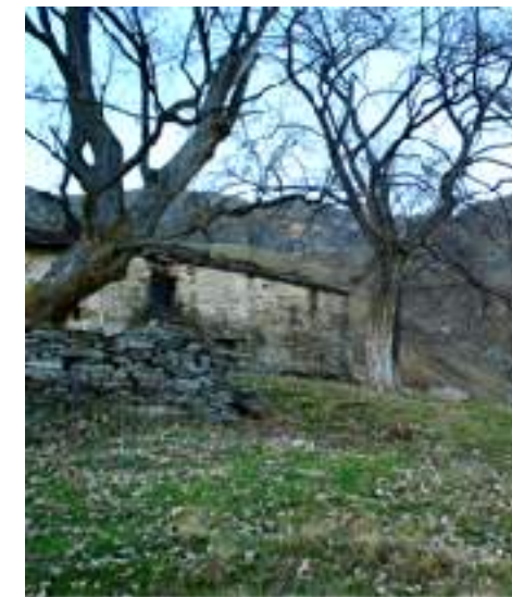
Edificio stagionale in pietra ad un
