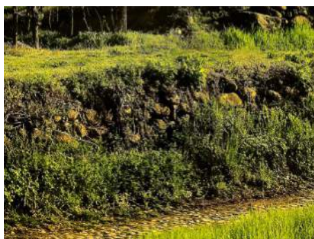
Muretto di contenimento a Cuceglio
