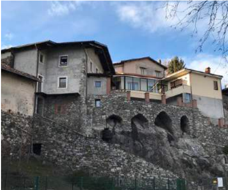
Muri di contenimento ad archi in pietra.
