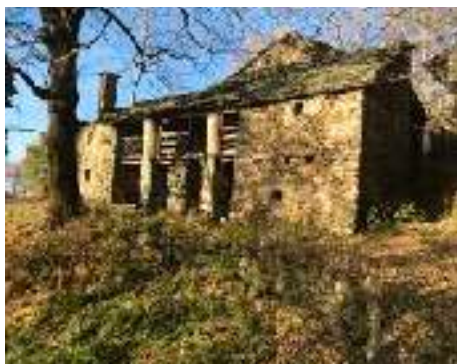
Casa con disposizione simmetrica della facciata: muri pieni laterali e parte centrale a pilastri in pietra quadrati al pino terreno e circolari al primo piano
