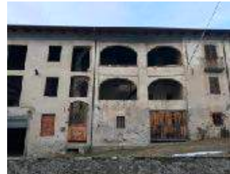
Casa ad archi e loggiati asimmetrici su due piani
