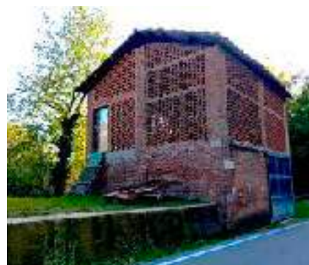
Fienile e deposito attrezzi con pareti a graticcio in laterizio
