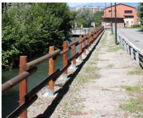
Muro di sponda in cemento con alla base recinzione in legno.
