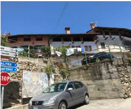
Muri di contenimento in pietra e cemento armato.
