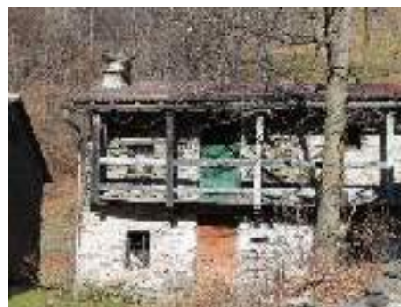
Casa di tipo di pianura con ballatoio al primo piano
