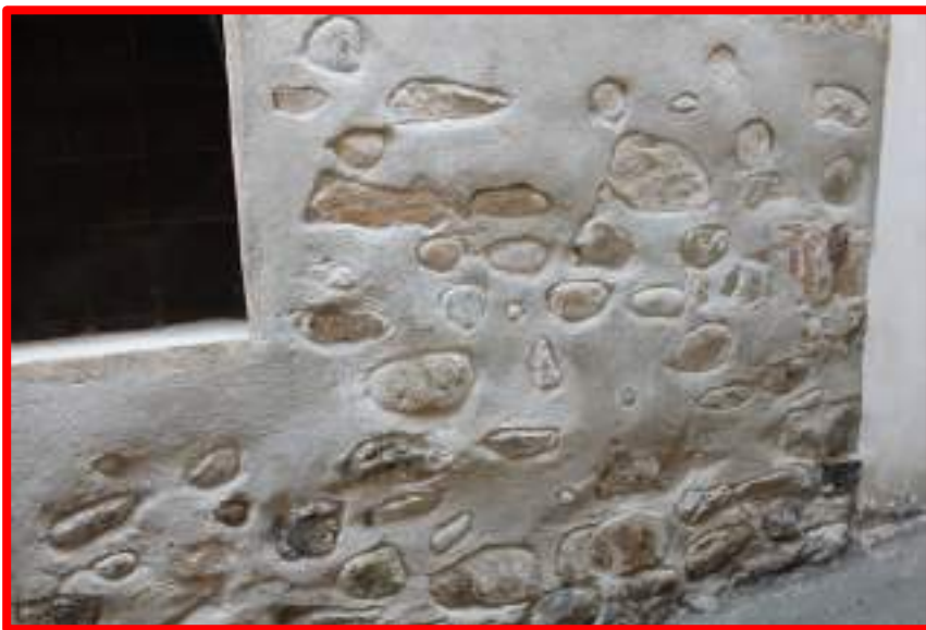
Figura 114: stesa dell'intonaco non compatibile
