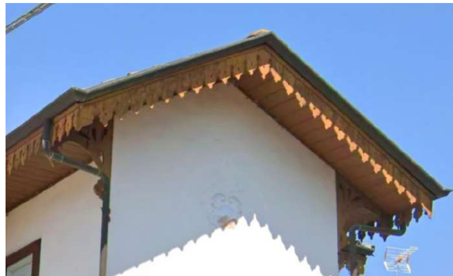
Figura 4: Montalenghe - particolare dei lambrecchini intagliati a contorno delle falde sostenute da montanti in legno modanato che si rifanno alla tipologia "a chalet"
