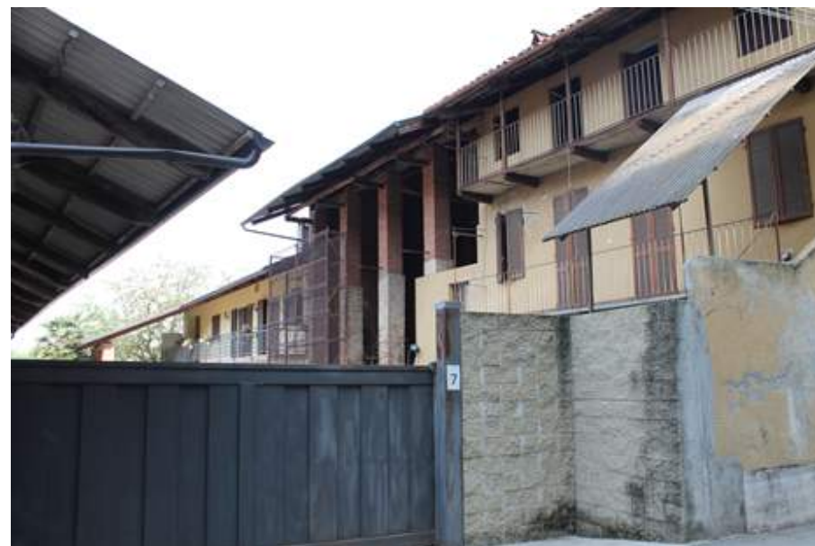
Figura 86: San Giorgio Canavese - aperture rettangolari con pilastrature in laterizio
