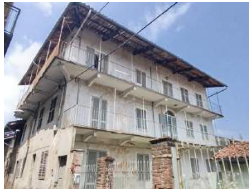
Figura 14: Azeglio – particolare dello sporto di edificio ad angolo
