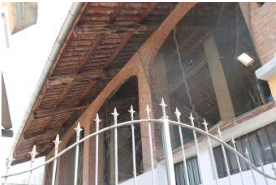
Figura 91: Caravino – aperture scandite da pilastrature ad arco
