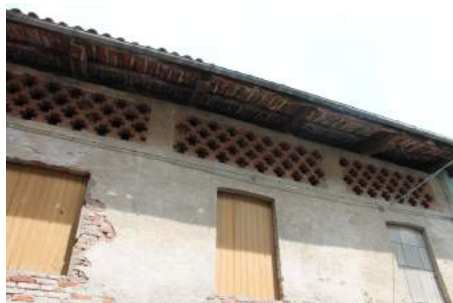
Figura 48: San martino Canavese - finestre sottotetto con chiusura in grigliato di mattoni
