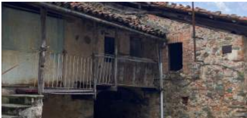
Figura 147: Strambinello – balcone con struttura lignea e ringhiera in ferro a sostituzione dell'originaria in legno
