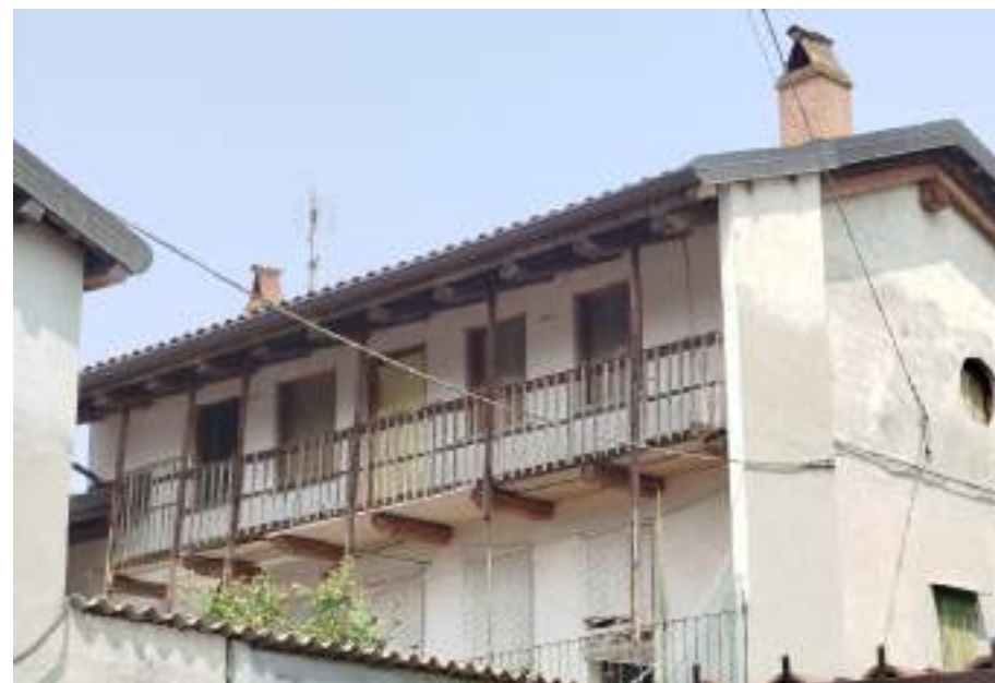
Figura 124: Azeglio - ballatoio interno con struttura lignea e aggancio all'orditura del tetto
