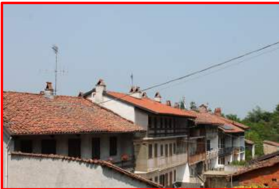
Figura 39: prediligere il recupero del coppo originale nel caso di rifacimenti
