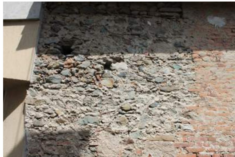
Figura 105: Bollengo – muratura in pietra intonacata
