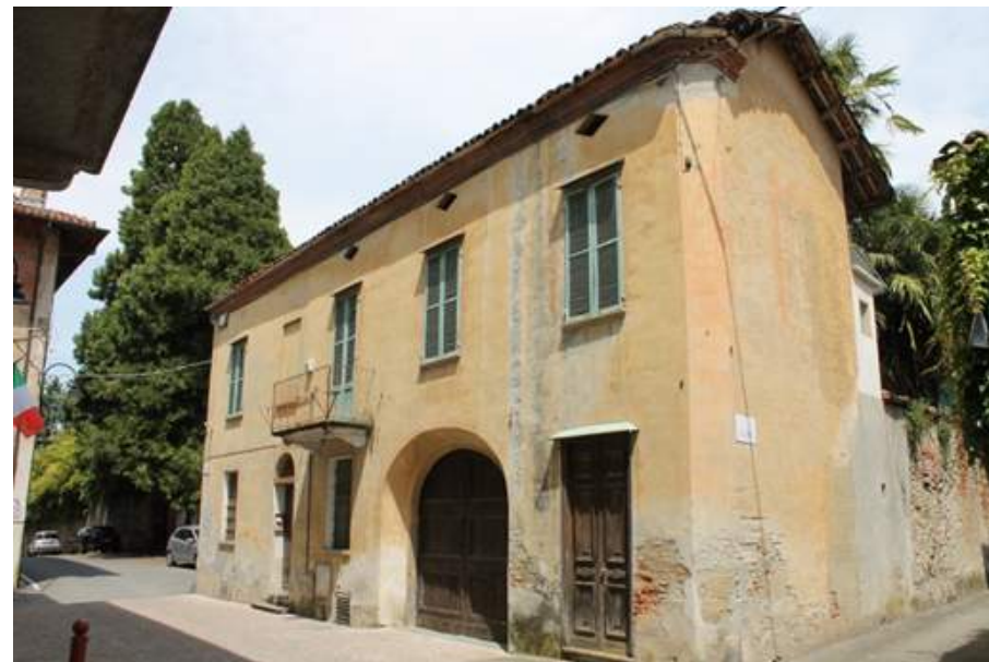
Figura 9: Piverone - cornicione con elementi di laterizio e risvolto sulla facciata laterale
