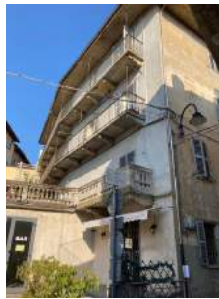
Figura 145: Ivrea – ballatoio in pietra con mensole
