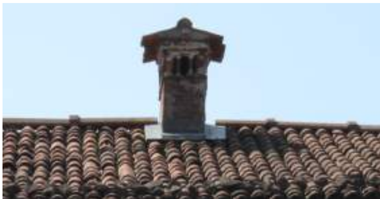
Figura 32: Cascinette – comignolo con copertura a capanna
