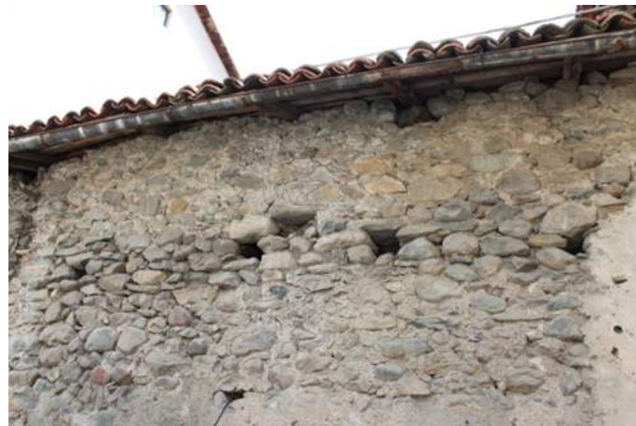
Figura 106: Bollengo – muratura in pietra intonacata
