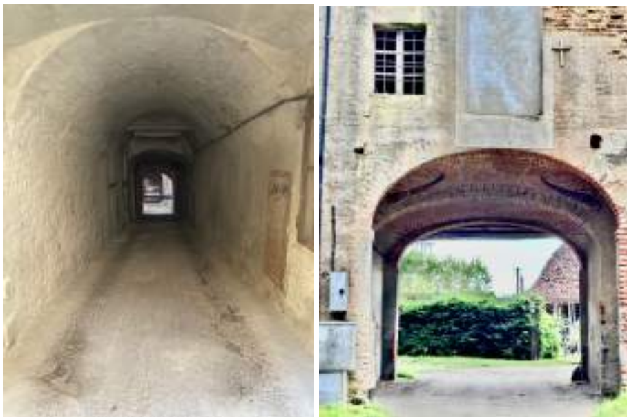
Figura 156: Ivrea – passaggio voltato intonacato (sx) Albiano - volta con lunette (dx)
