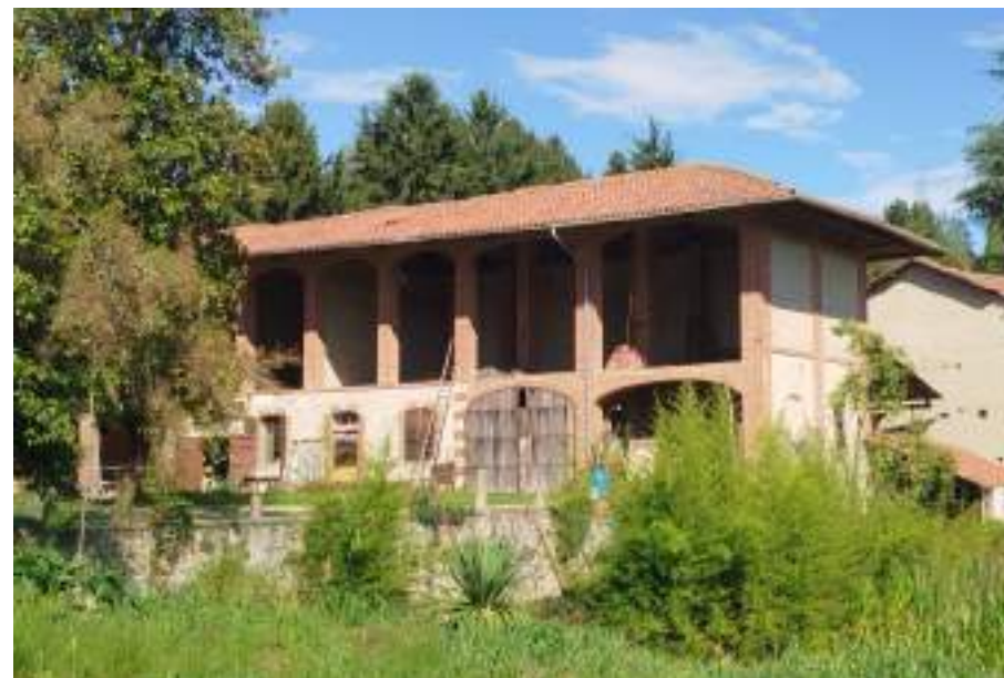
Figura 94: Albiano – aperture ad arco con pilastrature in laterizio
