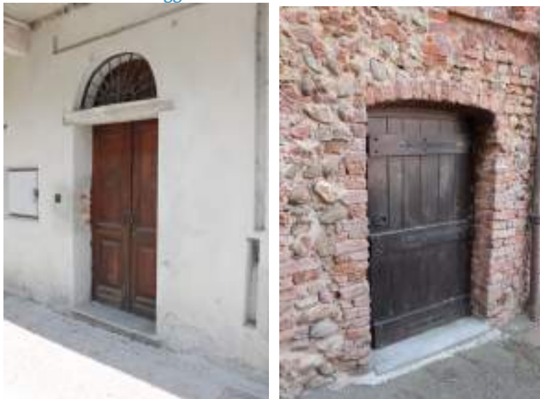
Figura 72: Piverone - portoncino a doppio battente con architrave in pietra e sopra luce ad arco con inferriata a raggiera
