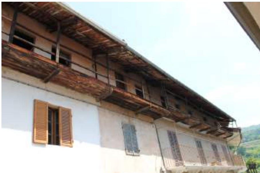
Figura 128: Bollengo - ballatoio ligneo all'ultimo piano con aggancio all'orditura del tetto
