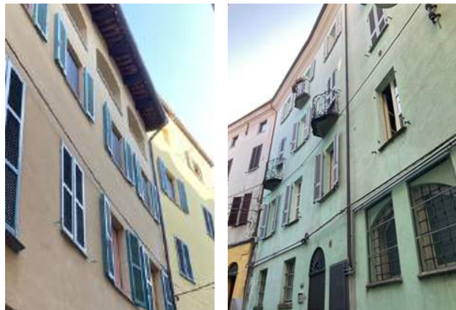
Figura 23: Ivrea – tetti con sporto a vista e cornicione intonacato
