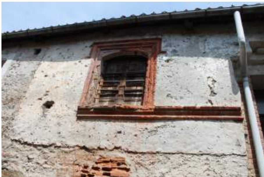
Figura 56: Bollengo – apertura con cornice in laterizio
