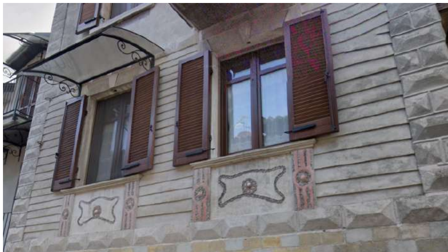
Figura 2: San Martino Canavese - paramento di facciata con bugne a diamante e inserti in rilievo
