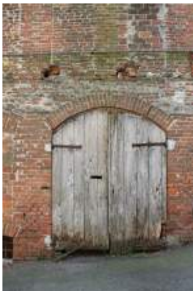
Figura 81: Borgomasino - accesso carraio in legno con arco in laterizio
