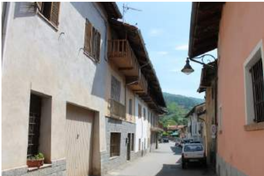
Figura 3: Burolo – sporto a protezione del ballatoio all'ultimo piano
