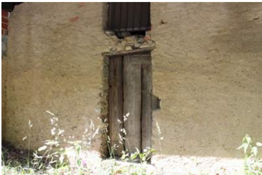
Figura 108: Burolo – muratura intonacata
