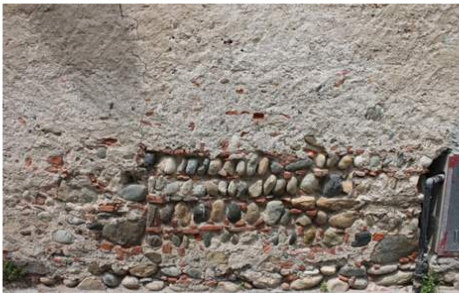
Figura 100: Scarmagno - muratura in pietra con corsi regolari alternata a mattoni
