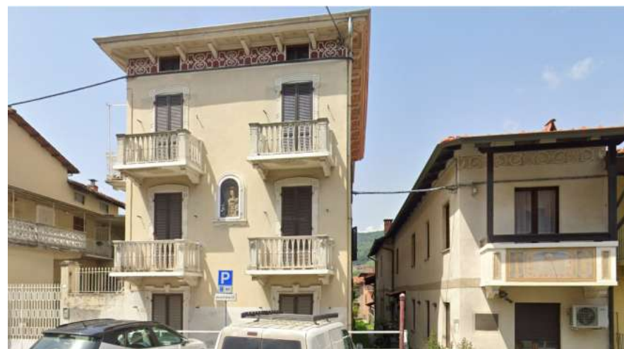
Figura 10: Bollengo: a sx edificio con cornice decorata e balconi in litocemento. A dx balastra del balcone affrescata
