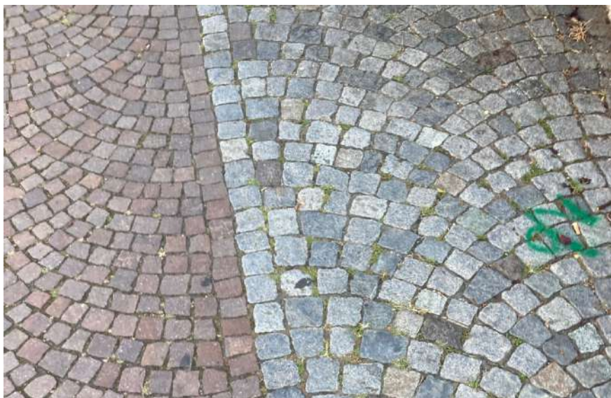
Figura 37: Ivrea - accostamento tra ciottoli e cubetti di porfido
