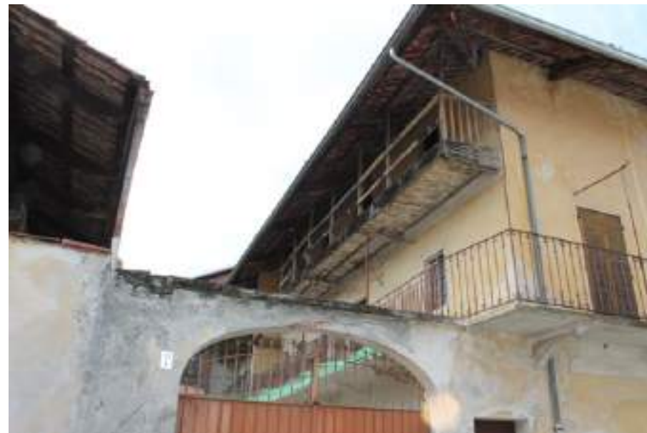
Figura 13: Scarmagno – sporto a protezione del ballatoio all'ultimo piano
