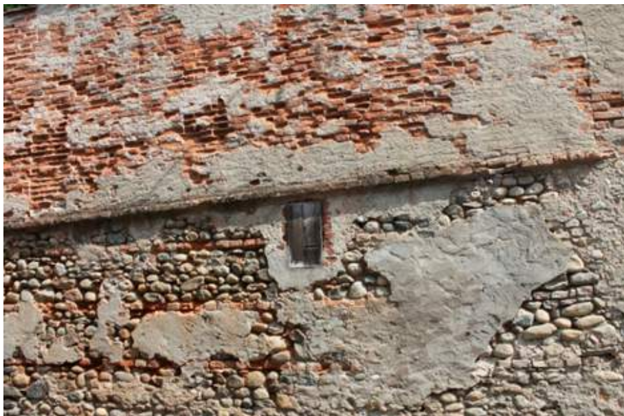
Figura 103: Montalenghe – muratura in pietra e in laterizio al secondo piano
