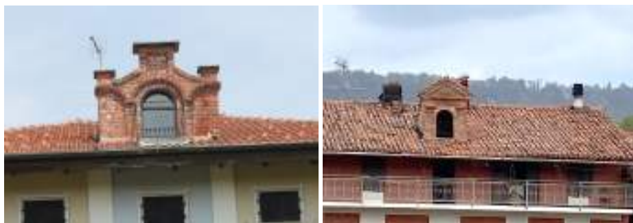
Figura 28: Borgomasino – abbaino con struttura a mattoni e tetto a capanna
