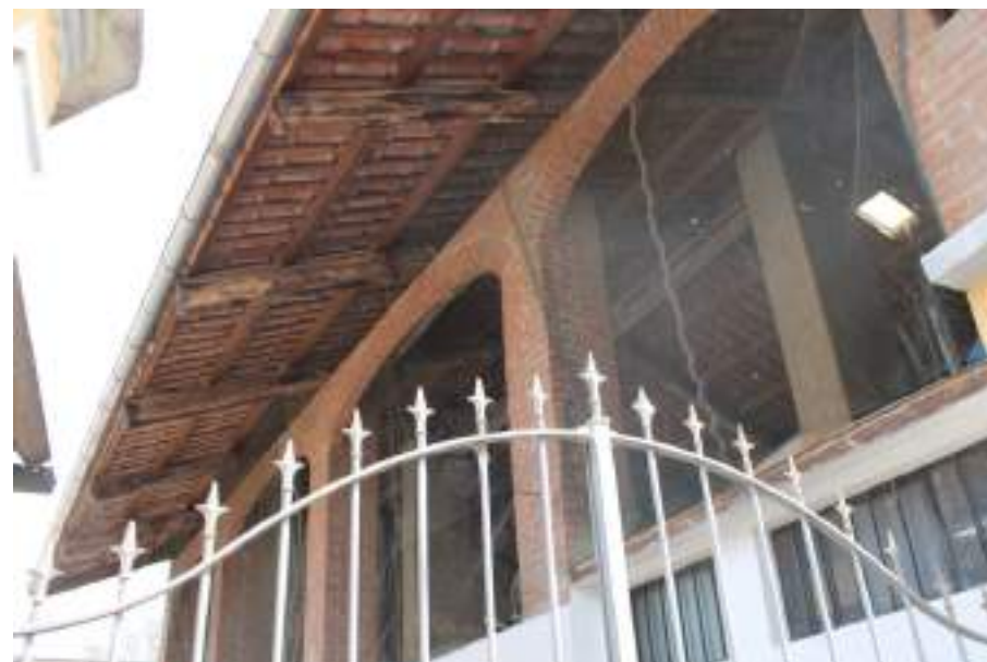
Figura 18: Caravino – dettaglio dell'orditura lignea di un fienile
