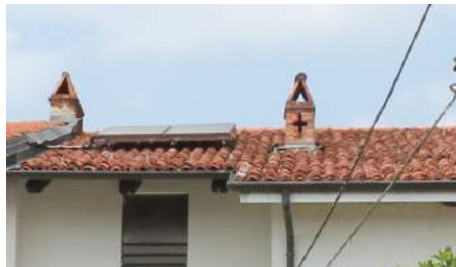
Figura 30: Borgomasino – comignolo con copertura a capanna in elementi di laterizio e apertura a croce sul fusto
