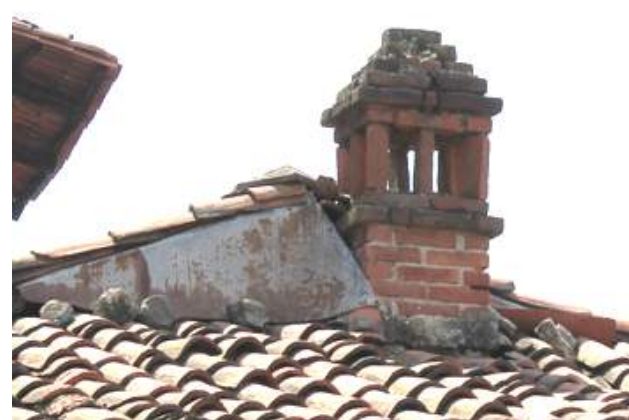
Figura 31: Borgomasino – comignolo con copertura piramidale poggianti su gambette in elementi di laterizio
