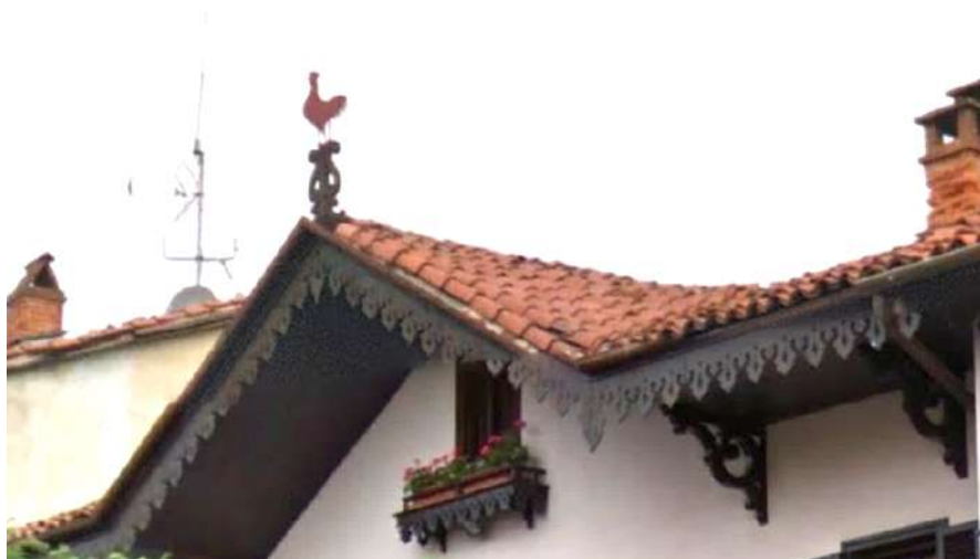
Figura 7: Azeglio - particolare dei lambrecchini con mensole decorate a sostegno dello sporto e tetto con tipologia "a chalet"
