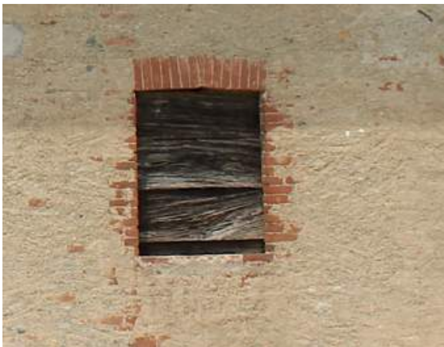
Figura 60: Scarmagno – anta unica cieca
