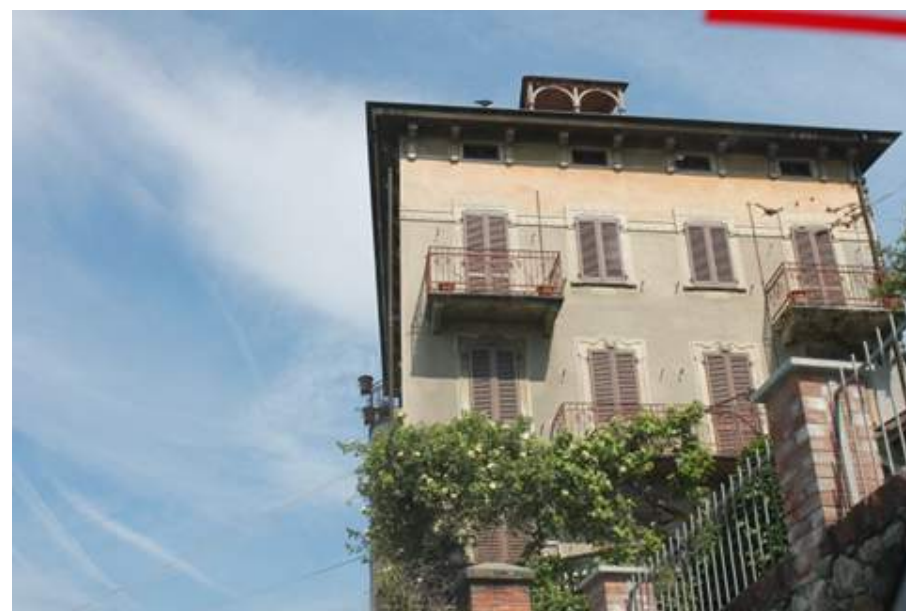
Figura 6 : Burolo – sporto decorato con mensole a cornice delle finestre sottotetto
