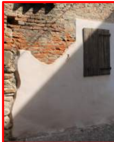
Figura 115: stesa dell'intonaco a macchia
