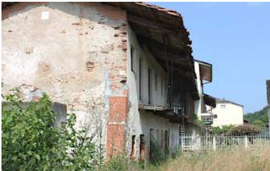
Figura 19: Settimo Rottaro – sporto a protezione del ballatoio
