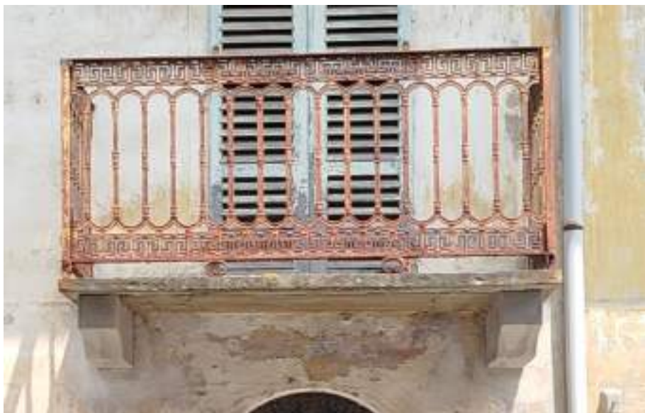
Figura 125: Azeglio - balcone con lastra in pietra e balaustra in ferro lavorata
