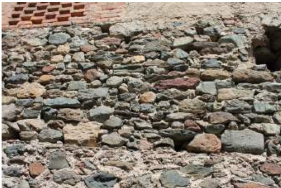
Figura 107: Bollengo – muratura in pietra intonacata
