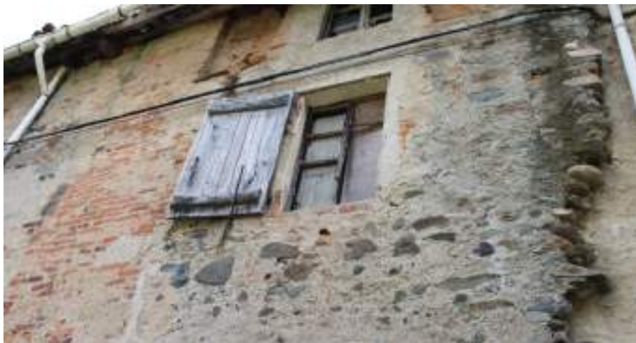
Figura 59: Piverone – anta cieca ad unico battente
