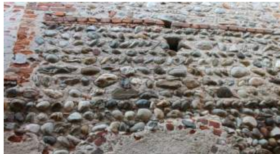
Figura 97: San Giorgio Canavese – muratura in pietra con corsi regolari alternata a mattoni
