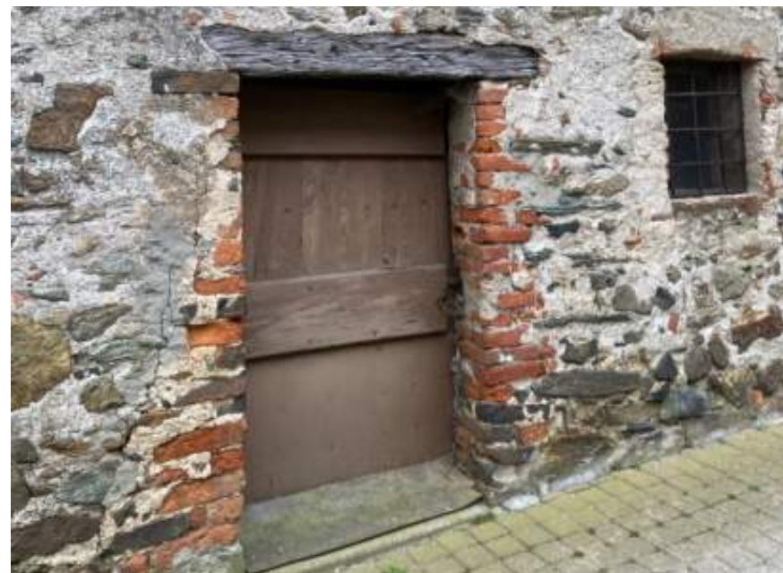
Figura 52: Strambinello - architrave in legno
