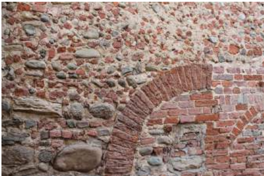
Figura 99: San Giorgio Canavese– muratura mista in laterizio
