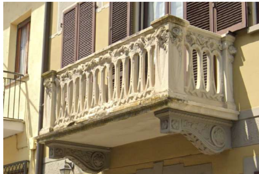
Figura 12: Bollengo - balcone in litocemento con motivi floreali
