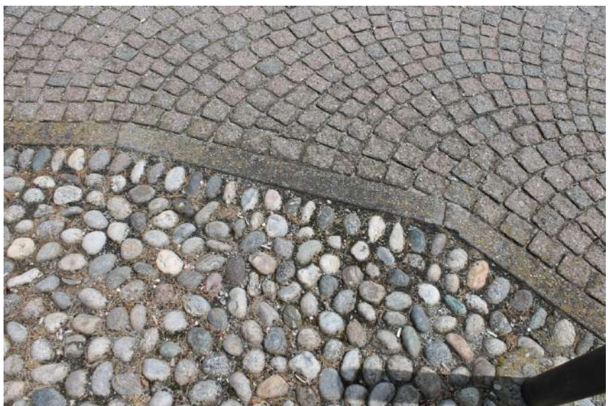
Figura 29: Piverone – accostamento tra ciottoli e cubetti di porfido
