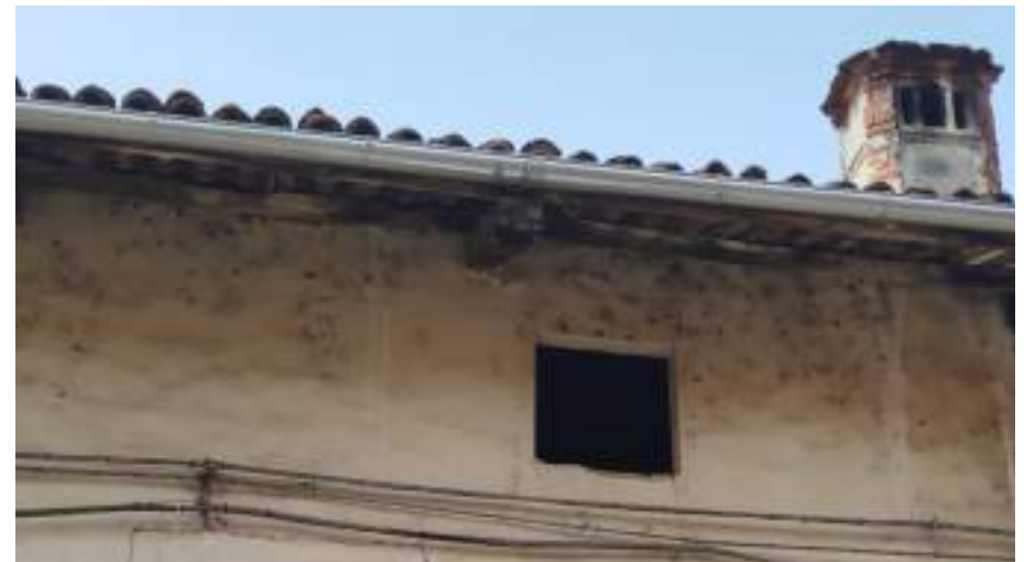
Figura 112: intonaci ammalorati sottogronda
