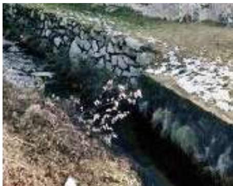
Due diversi muri di sponda accostati, uno in massicciata l'altro in cemento.
