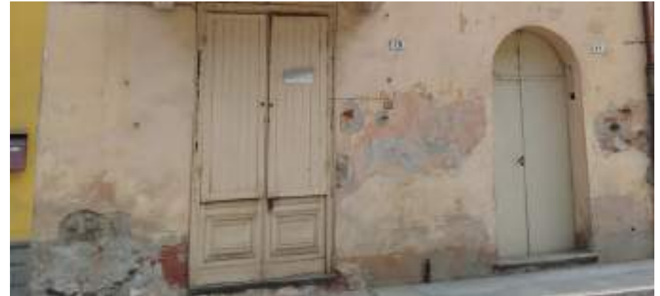
Figura 111: distacco di intonaci
