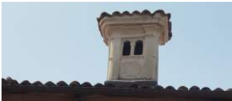
Figura 33: Albiano – comignolo intonacato con copertura piana in coppi
