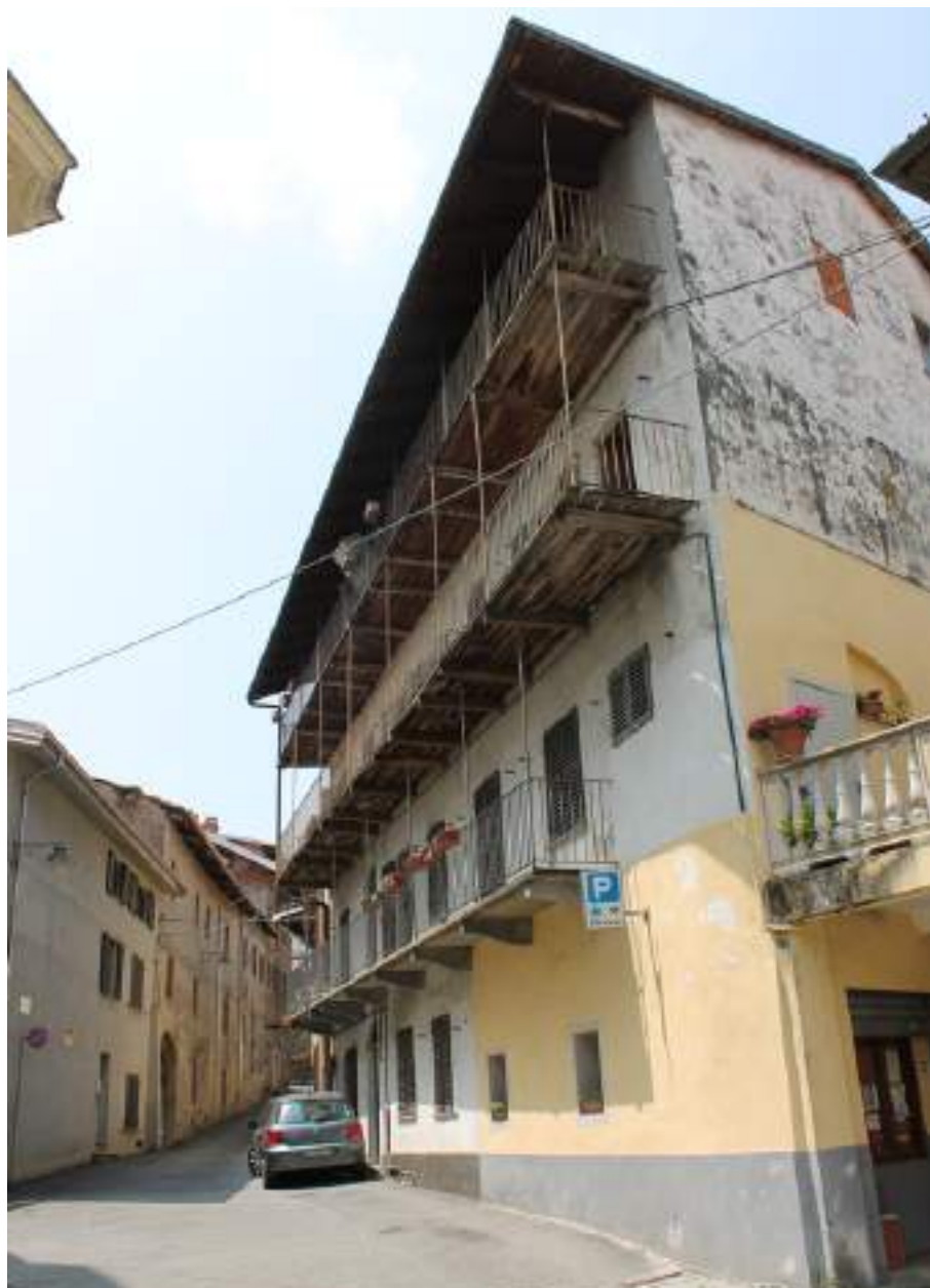
Figura 132: Borgomasino – balcone al primo piano e ballatoio ligneo in linea su due piani
