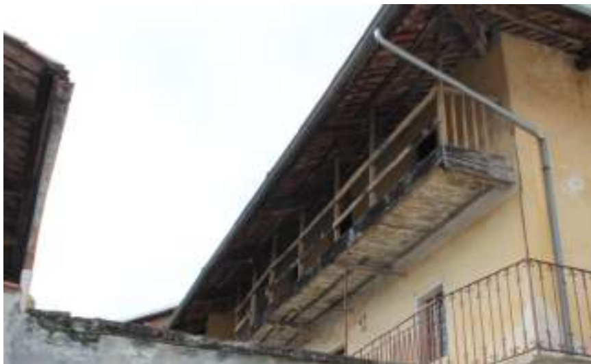
Figura 146: Scarmagno – ballatoio all'ultimo piano con struttura lignea, aggancio al tetto e tavola fermapiède in legno
