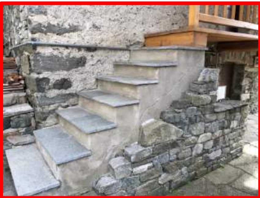
Figura 122: scala in calcestruzzo e pedana lignea
