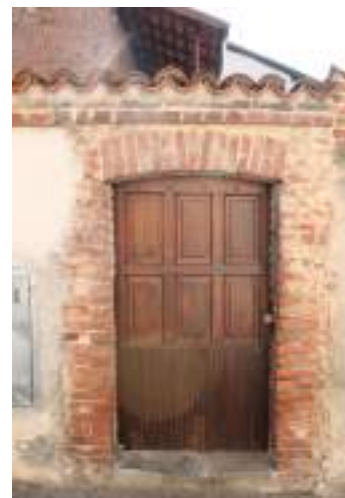
Figura 53: Montalenghe - piattabanda in mattoni
