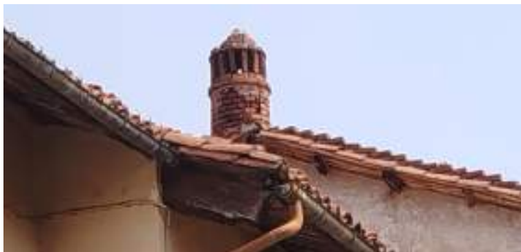
Figura 34: Albiano – comignolo con fusto circolare e copertura a cono
